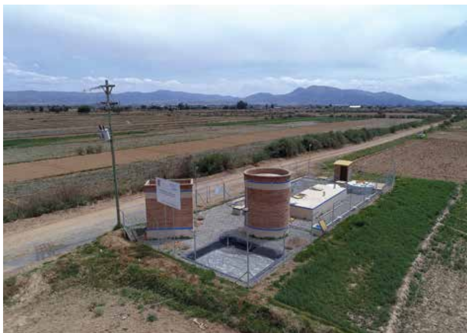
Detalle de las instalaciones para el tratamiento de aguas residuales en San Isidro (Valle Alto de Cochabamba).
