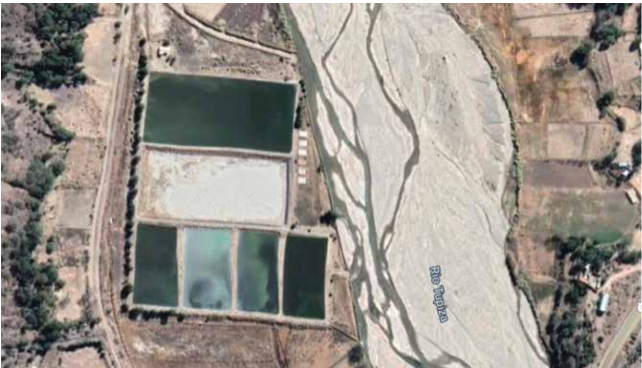
Figura 3 Vista de la PTAR de Tupiza (2021)
