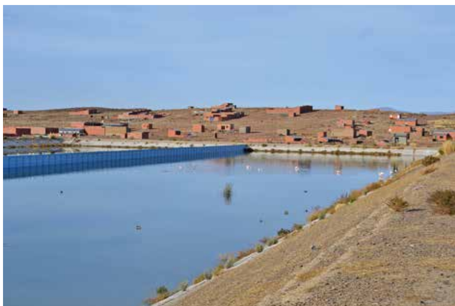
Sistema de lagunaje para el tratamiento de aguas residuales en la localidad fronteriza de Villazón (Potosí), municipio de unos 50 mil habitantes.
